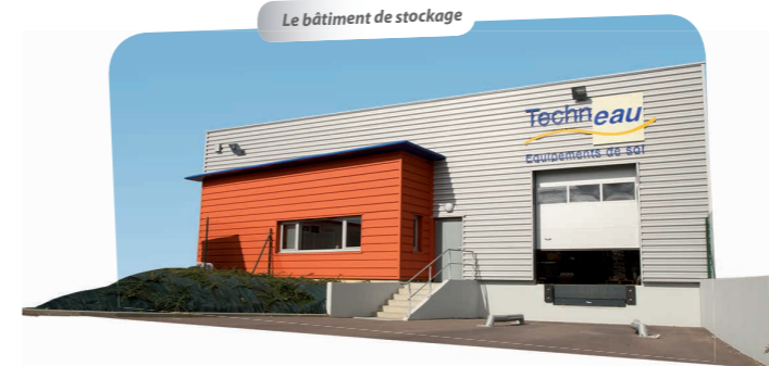
Le bâtiment de stockage
